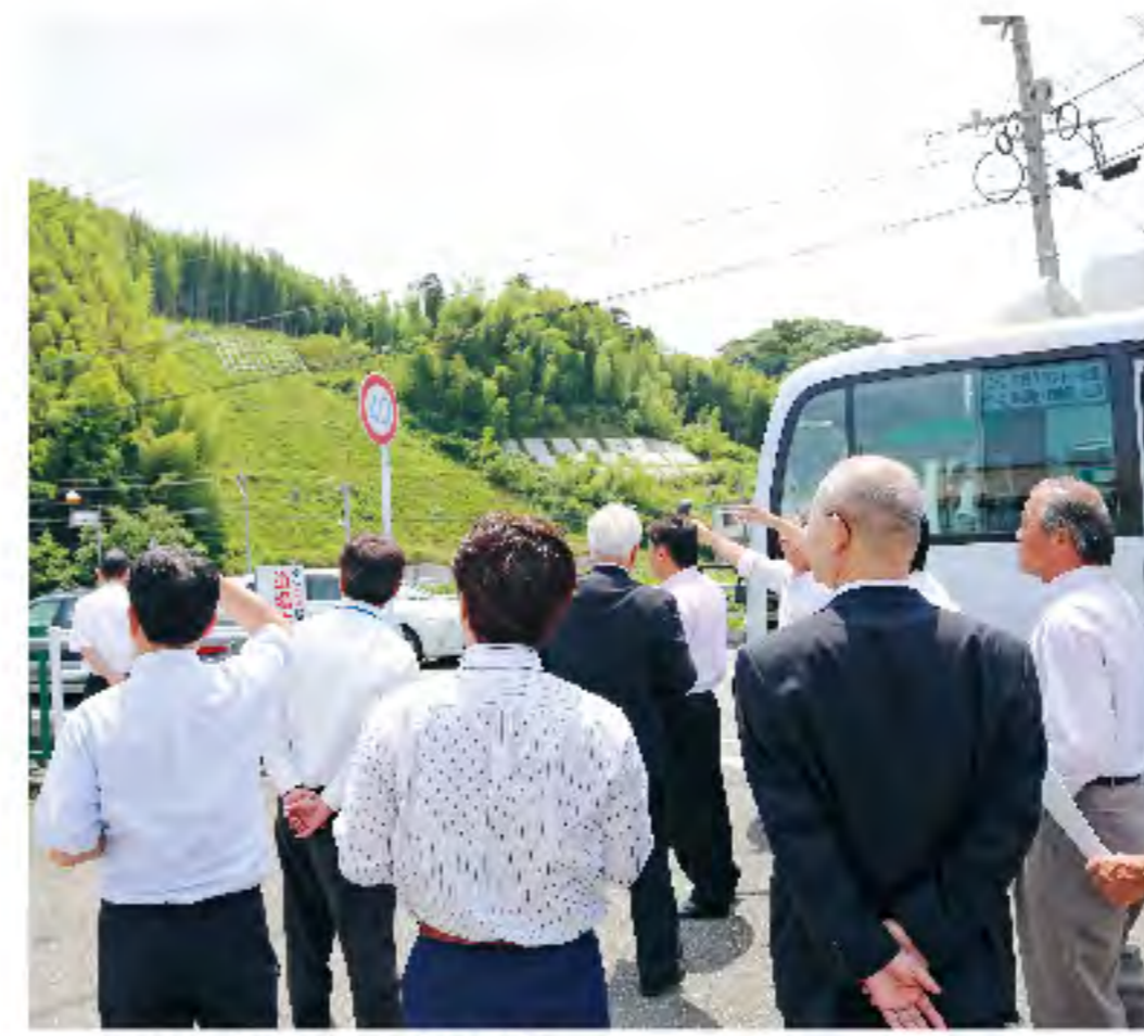
瀬戸土砂崩れ箇所を視察
