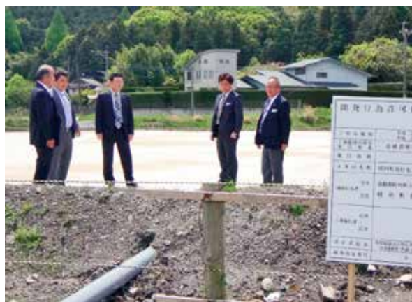
町営二反田団地を視察
