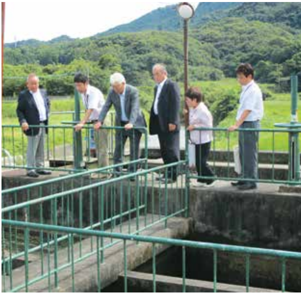
土師浄水場視察
