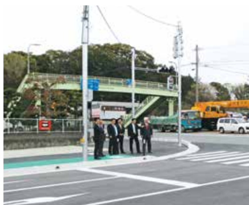
桂川駅南側道路
