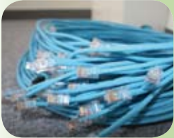
▲ コンピュータ増設用のネットワークケーブルの束
