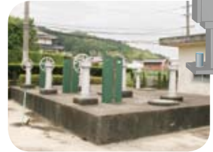
▲きれいになった水に、ここで塩素注入を行い殺菌された安全な飲み水が完成します。このあと配水池へポンプで送水します。
