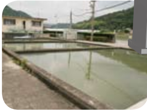
▲玉砂利、ろ過砂などの層を通ることによりゴミや不純物が取り除かれ、薬品を極力使わず安心・安全な水を作る昔から行われている方法です。
