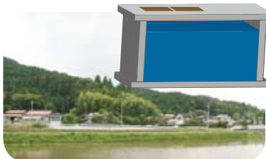
▲浄水場近くの山の上にあります。動力は使わず、高低差を利用して、皆様のご家庭の蛇口へと水道水を送っています。
