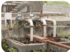
▲泉河内川の水を取水源とする土師浄水場の取水ポンプ
