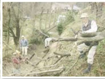
▼生き茂った木々の伐採、剪定作業風景
