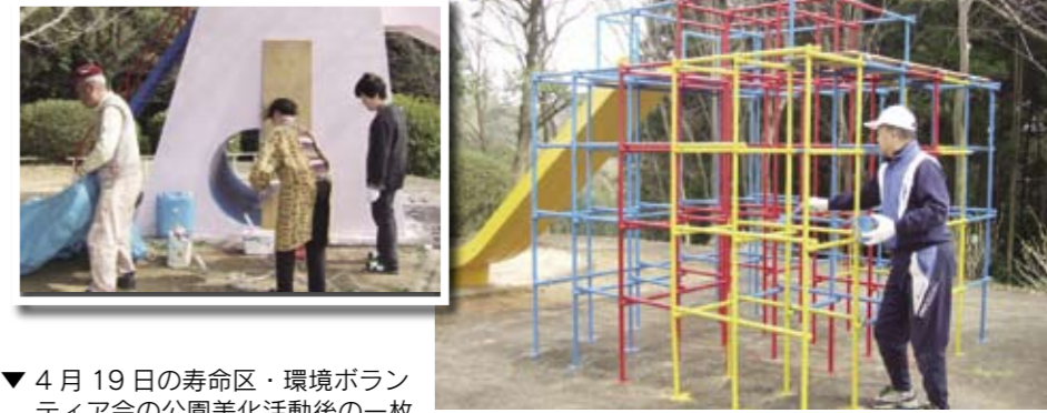
▲▼スベリ台など遊具の塗り替え作業風景
