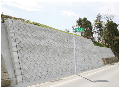
▲修復が完了した道路法面
