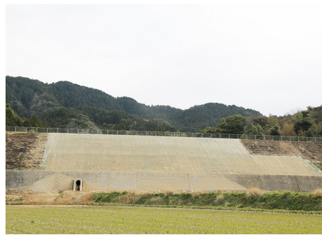
▲修復が完了した狩野ため池
