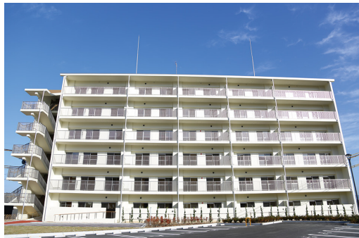
▲H30年11月に完成した二反田団地A棟。
