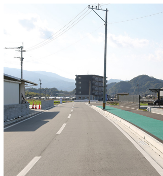
▲完成した駅南側道路
