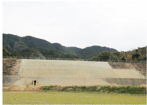
▲修復が完了した狩野ため池
