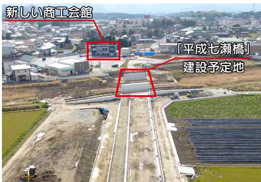
▲工事が進む県道豆田稲築線の一部
