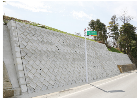
▲修復が完了した道路法面
