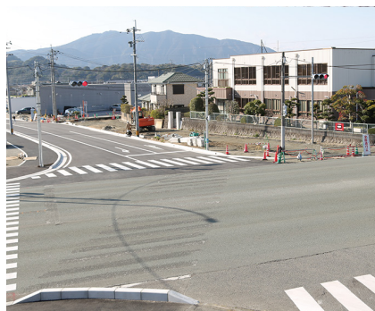
▲旧諫山医院前の交差点工事の様子 (H31年3月上旬)
