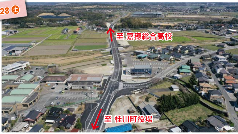
▲ドローンで撮影した県道豆田稲築線（土師工区）
