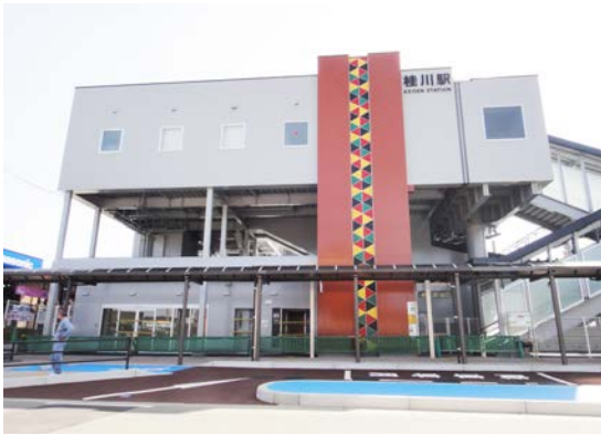
▲完成した桂川駅北側駅舎
