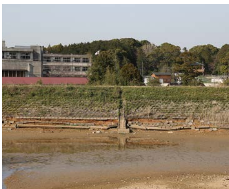
▲改修工事をおこなう七浦ため池
