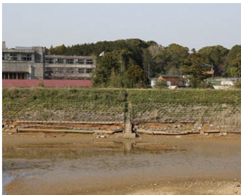
▲改修工事をおこなう七浦ため池
