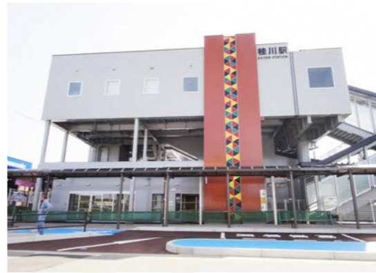
▲完成した桂川駅北側駅舎
