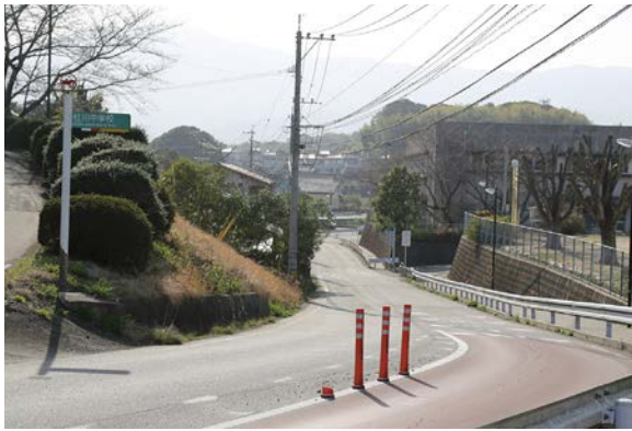
▲県道豆田稲築線（九郎丸工区）の一部
