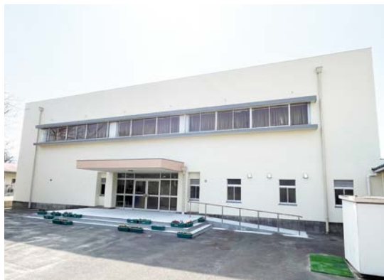
▲ 体育館も外壁塗装を施しました
