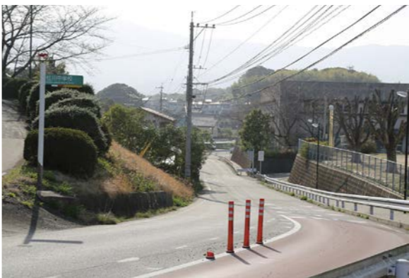
▲県道豆田稲築線(九郎丸工区)の一部
