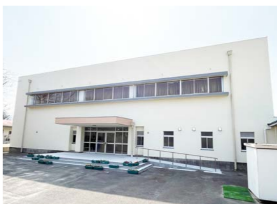
▲ 体育館も外壁塗装を施しました
