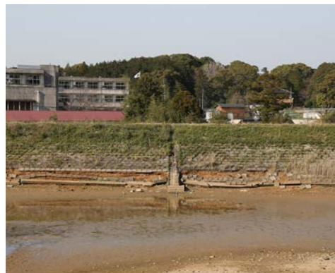
▲改修工事をおこなう七浦ため池
