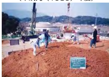
図 2-98：石室浸水対策工事(平成 14 (2002) 年度)
