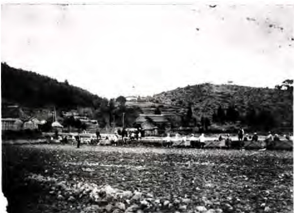
図2-30：石室発見の契機となった鉱害復旧工事
