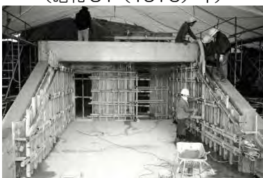
図 2-94：保存施設施工状況(昭和 62 (1987) 年度)
