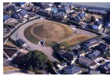
図 2-99：石室浸水対策及び後円部復元工事後の王塚古墳(平成 14 (2002) 年度)
