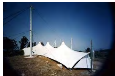
図 2-93：石室保護の養生テント(昭和 62 (1987) 年度)
