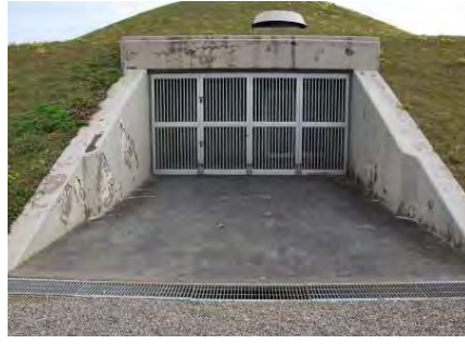
図 2-104：保存施設外観（近景）
