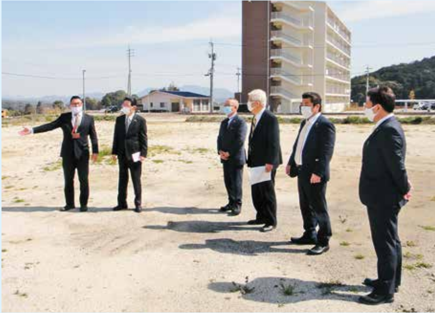
二反田団地B棟建設予定地（奥はA棟）
