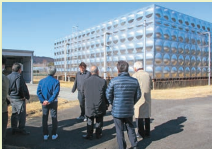
綾町の配水池
