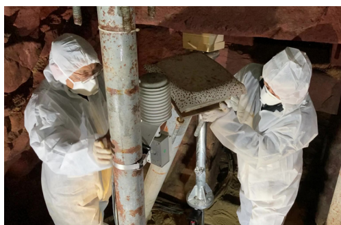
▲支柱の取り換え作業の様子
