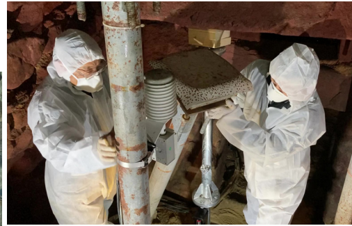
▲支柱の取り換え作業の様子
